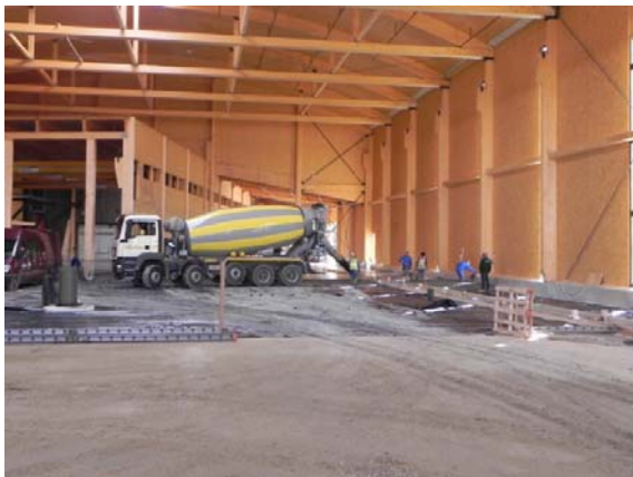
Bild 34) Betonboden mit Stahlfaserbewehrung. Max. fugenfreie Fläche 35/35 Meter
