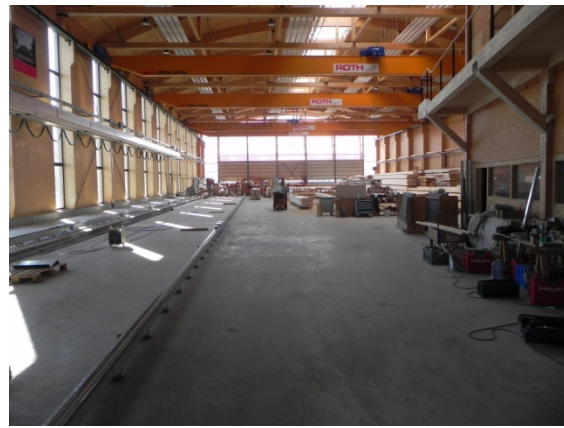
Bild 34) Betonboden mit Stahlfaserbewehrung. Max. fugenfreie Fläche 35/35 Meter
